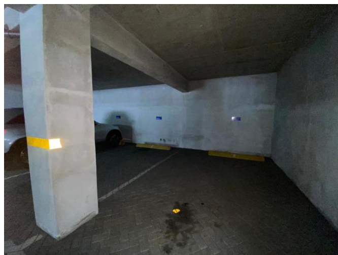
Foto 10. Estacionamientos en sótanos.
