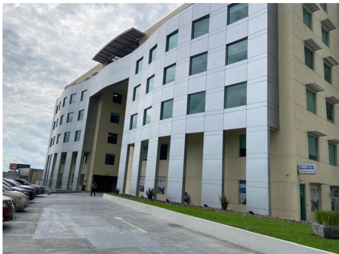
Foto 1. Vista exterior de la propiedad. (Edificio).
