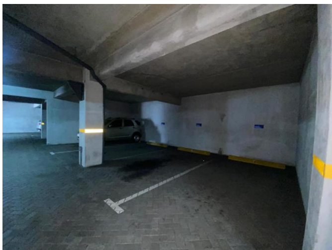
Foto 9. Estacionamientos en sótanos.
