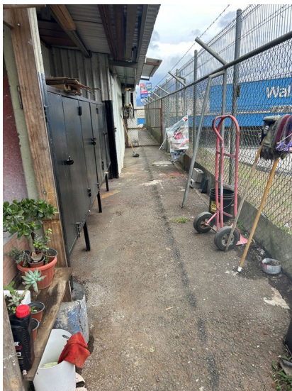
Vista externa de malla ciclón de cerramiento en costado sur.
