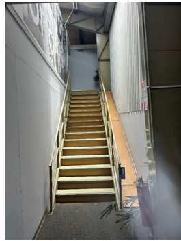
Vista externa acceso en fachada norte, hacia oficinas en 2do nivel mezzanine dentro de nave industrial.
