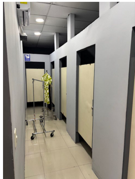
Vista interna de vestidores de finca filial 16 (tienda primer nivel).
