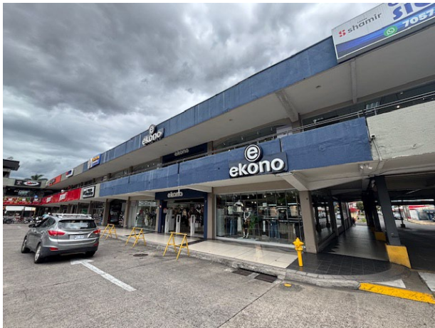
Vista de frente de fincas filiales 16 (primer nivel) y F (segundo nivel).
