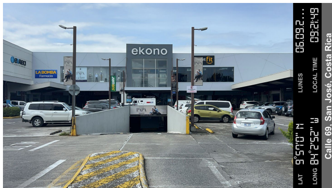
Vista general de inmueble y estacionamientos primer nivel.
