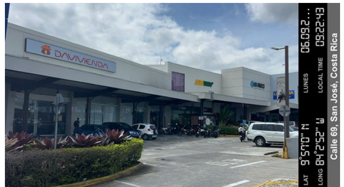
Vista general de inmueble y estacionamientos primer nivel.
