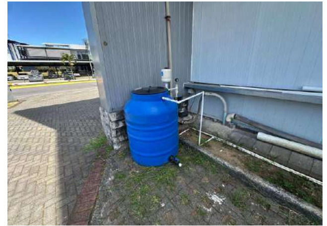
39-TANQUE AGUA NIVEL 3
