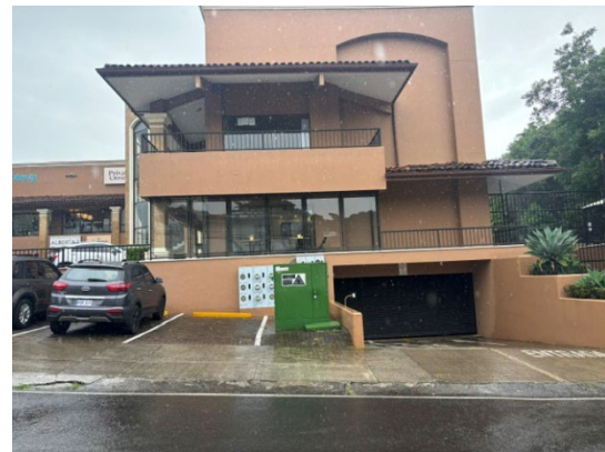
Vista costado sureste-entrada a sótano.
