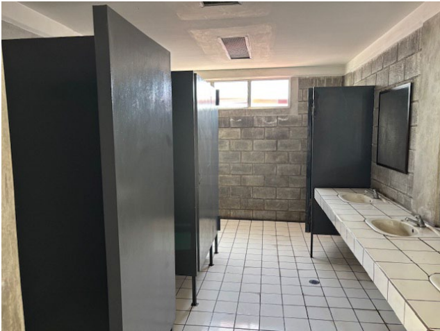
Vista interna de servicios sanitarios en área común.
