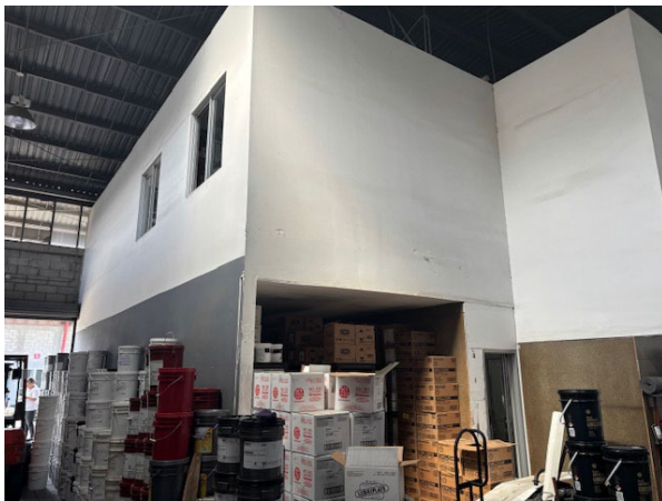
Vista externa de mezzanine FF13.
