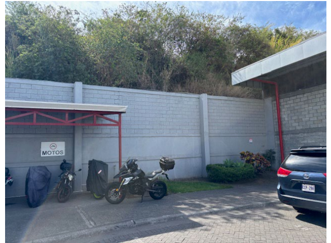
Vista de cerramiento (muro retención) en lindero este.
