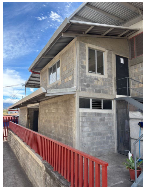
Vista de oficina administrativa (2do nivel), y servicios sanitarios (1er nivel).
