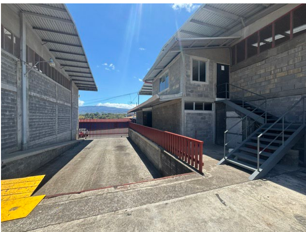
Vista interna de área de carga y descarga.
