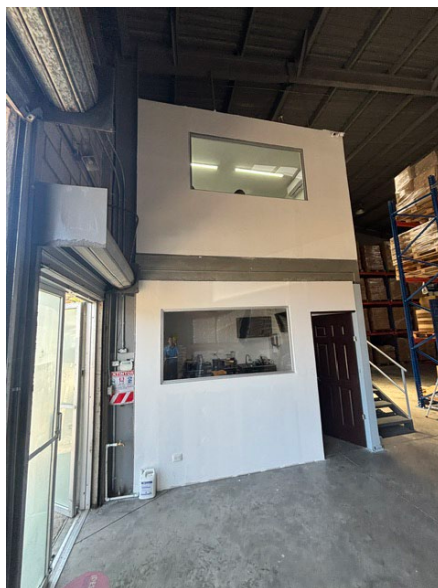
Vista interna de instalaciones sobre cielo de FF7.
