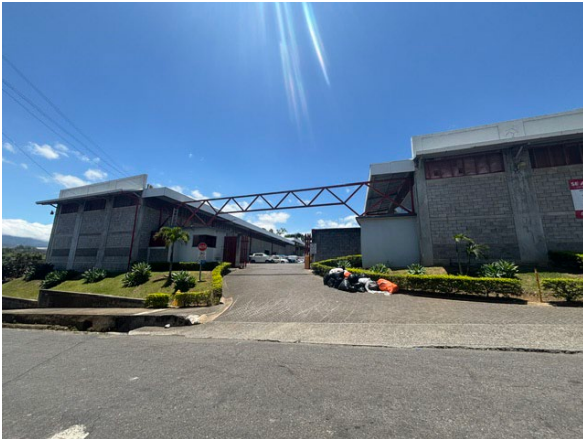
Vista de entrada frontal al inmueble en lindero oeste colindante con calle pública. A la izquierda caseta vigilancia, a derecha bodega de basura.
