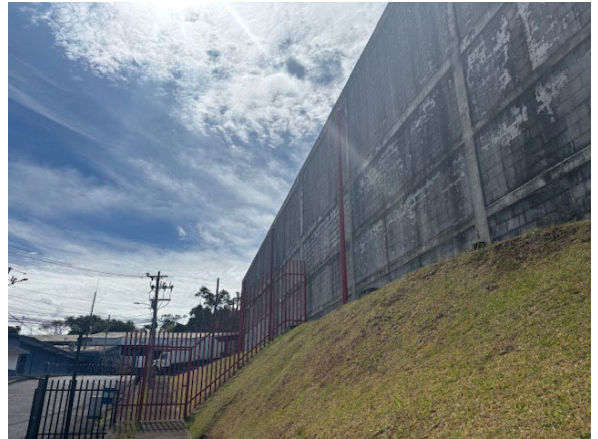
Vista de lindero norte y zona verde.
