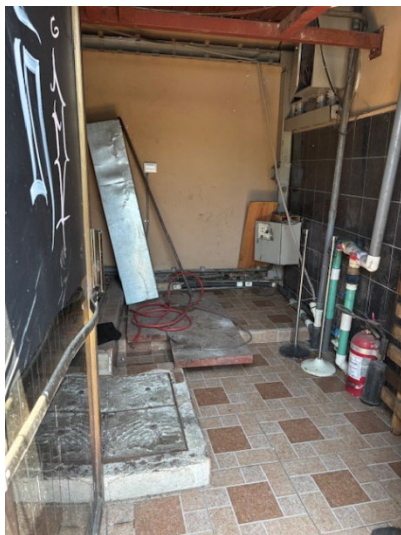
Vista de acceso a planta de tratamiento de aguas negras.
