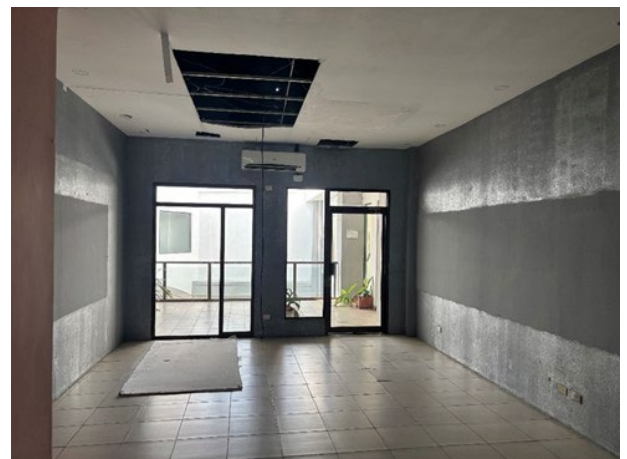
Vista interna de acabados de Local 18 (desocupado).
