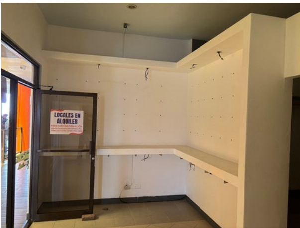
Vista interna de acabados de Local 3 (desocupado).
