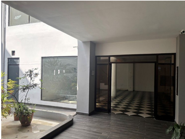
Vista externa de fachada de local 7.
