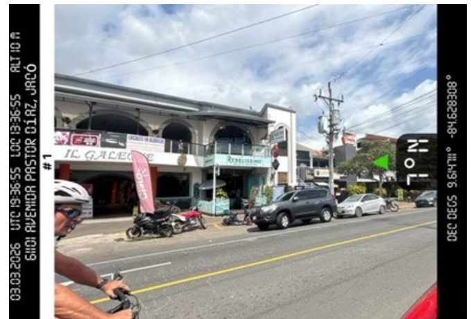
Vista de decks (estacionamientos) y fachada principal.
