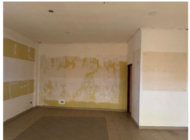
Vista interna de locales 14 y 15 (desocupados).
