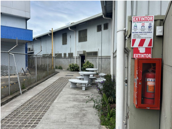
Vista de aceras y zona donde se ubica Fosa de Tratamiento de aguas residuales.
