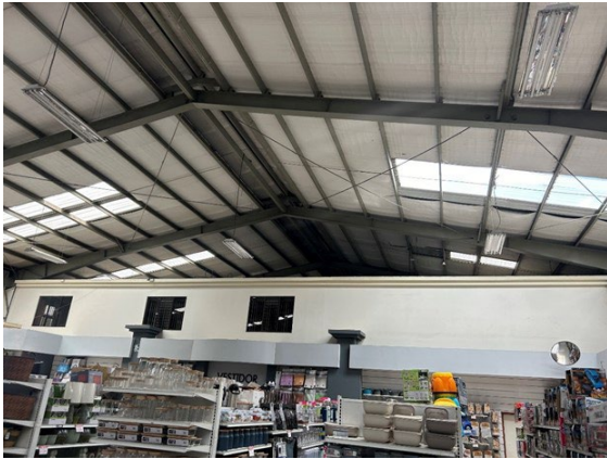
Vista de fachada externa de mezzanine de oficina administración, dentro de Nave Industrial.
