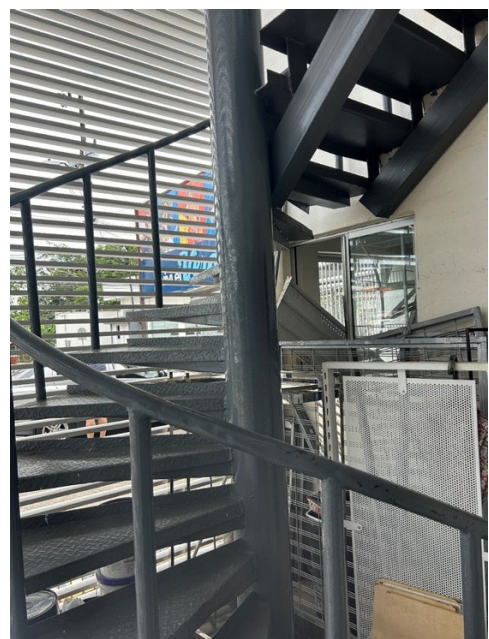
Vista interna de escalera metálica, dentro de módulo de costado este y frontal.
