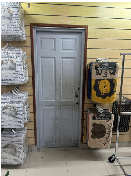
Vista interna bodega en costado oeste, dentro de Nave Industrial.
