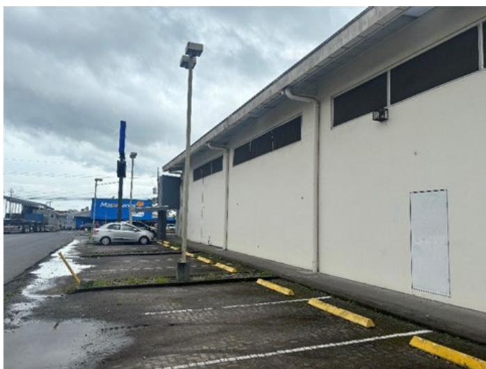
Vista externa fachada oeste.
