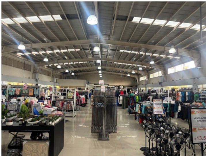
Vista interna tienda (Nave Industrial).
